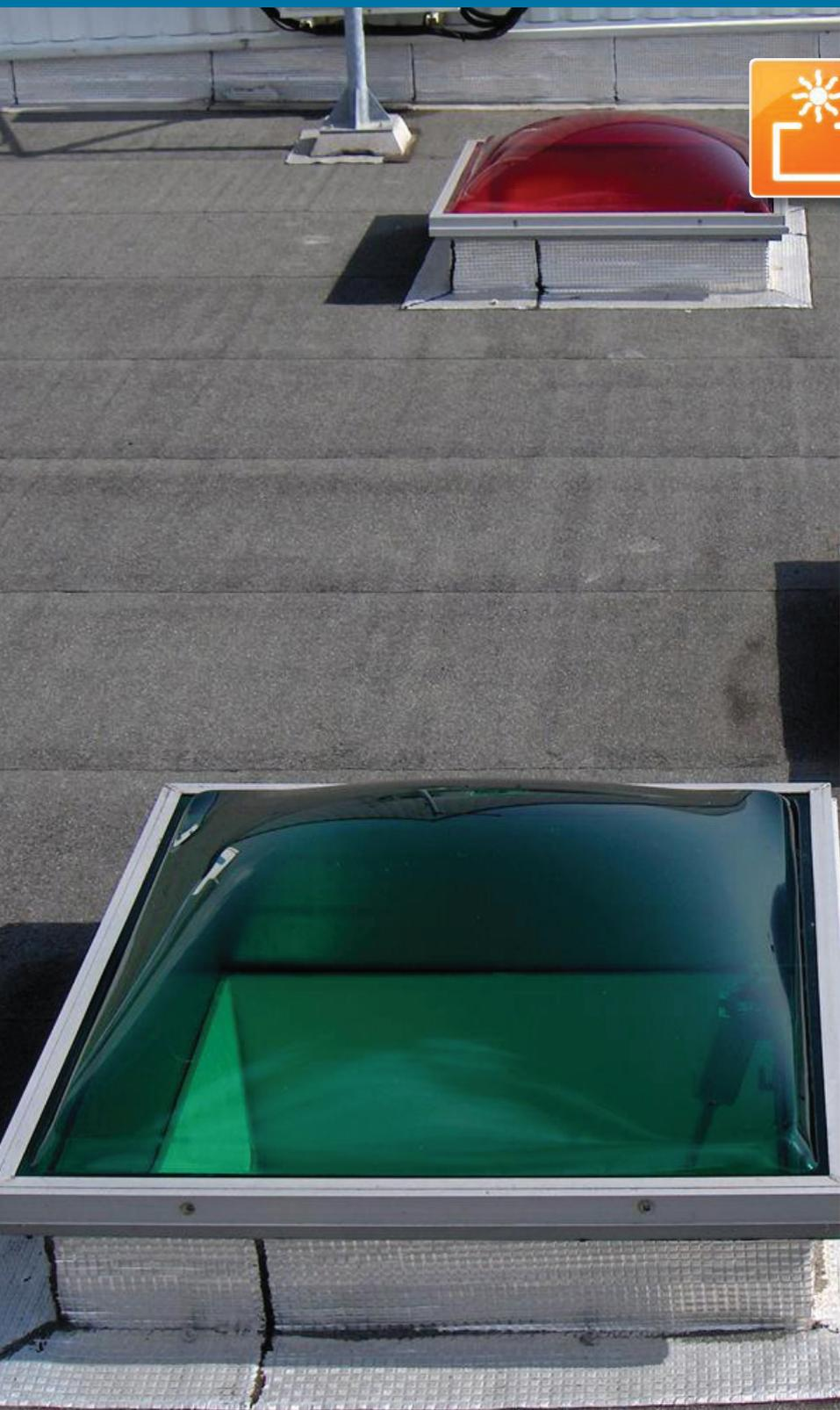
Le SKYDÔME® est un lanterneau ponctuel utilisé en toiture terrasse avec étanchéité, pour tous types de bâtiments (ERP, ERT, bâtiments industriels).
